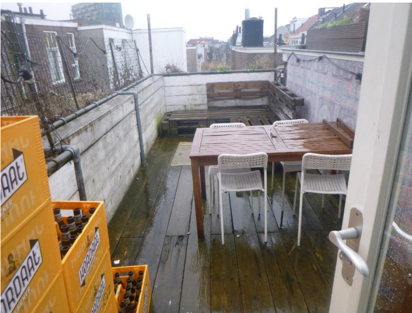
Foto 04: Dak aanbouw achterzijde; Er is een vlonder en balustrade gerealiseerd op het betreffende platte dak.
