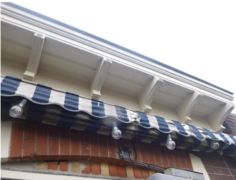
Foto 06: Overstek voorzijde; Het houtwerk behorende bij het overstek verkeerd in een goede staat.
