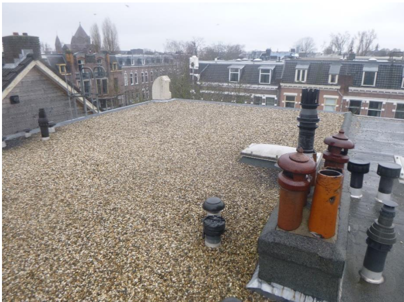
Foto 01: Hoofddak; Het dak is voorzien van ballastgrind.
