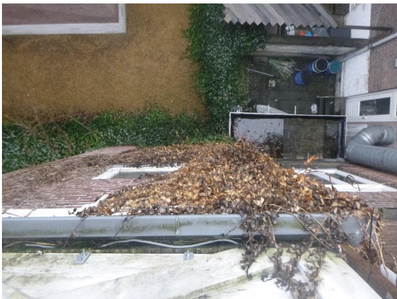
Foto 02: Achtergevel; Een gedeelte van de achtergevel was tijdens de inspectie niet bereikbaar via het bijbehorende perceel.
